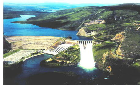
Usina Hidrelétrica de Furnas localizada entre os municípios de São José da Barra e São João B. do Glória
